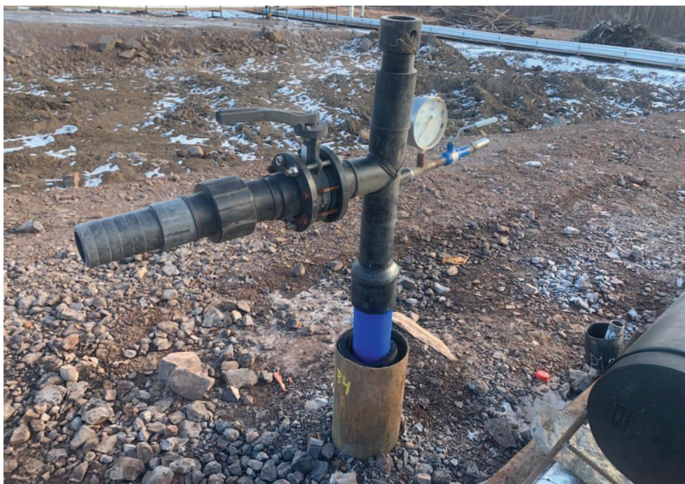
Рис. 6. Общий вид оголовника для выполнения пневмосвабирования Fig. 6. General view of the head for performing pneumatic swabbing
