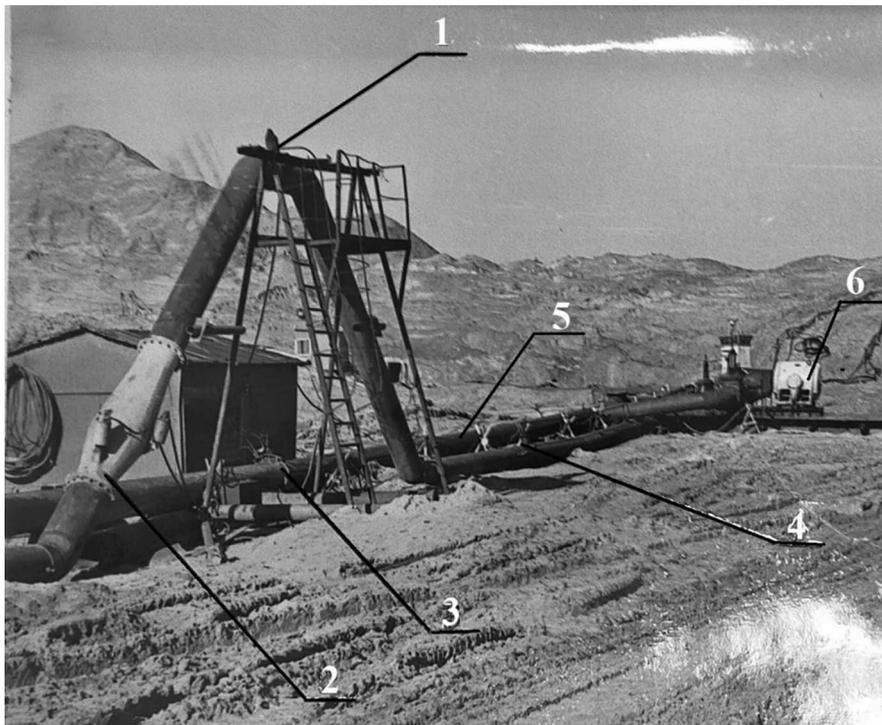
**Рис. 4.** Общий вид установки системы определения расхода и плотности гидросмеси: 1 — гидростатический плотномер; 2 — расширяющее устройство расходомера гидросмеси; 3 — диафрагма ДК-25-450; 4 — пульпо-вод Двнутр = 410 мм; 5 — водовод Двнутр = 450 мм; 6 — водяной насос 300Д-90
