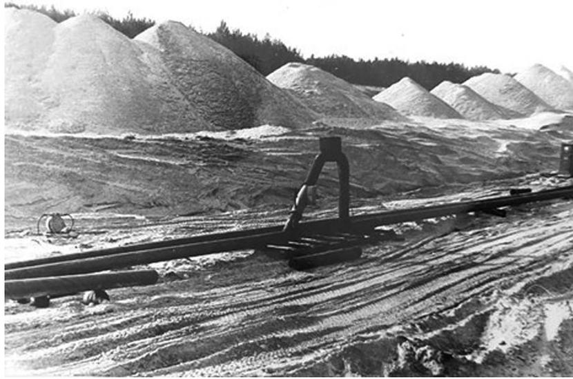
**Рис. 8.** Передвижная установка измерения параметров гидротранспортирования на расстоянии до 2 км из карьера на обогатительную фабрику
