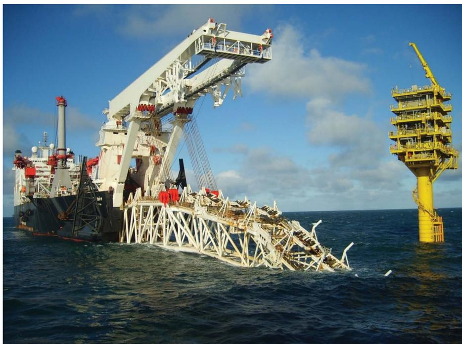
**Рис. 2.** Укладка трубы газопровода «Северный поток», 2010—2012 гг. [12]
