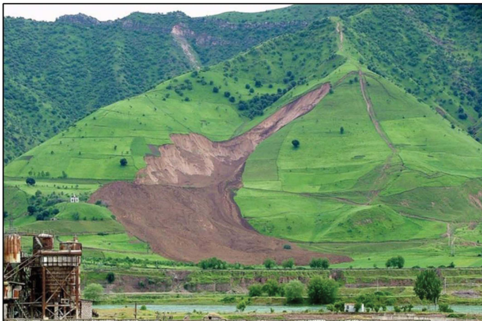
Рис. 4. Оползень в лёссах в г. Нурек, 2005 г. (фото Н.Р. Ищук)
