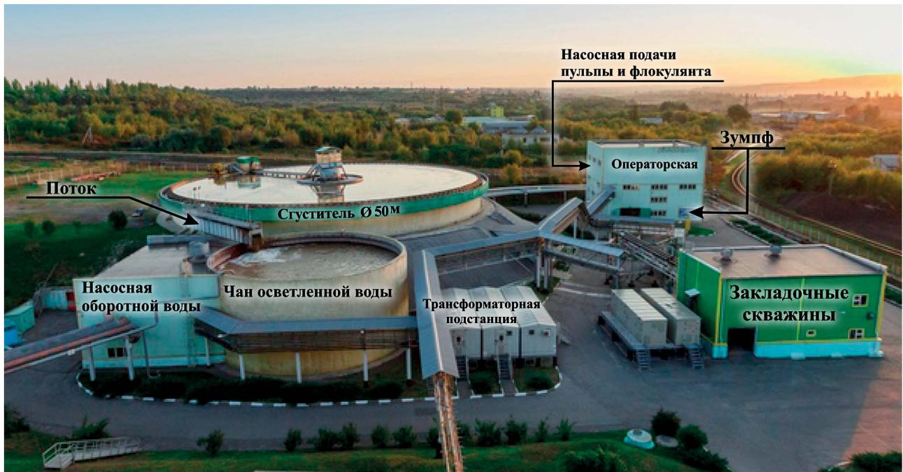
Рис. 1. Поверхностная часть закладочного комплекса
