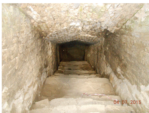
Рис. 2. Наклонный тоннель для водоснабжения, построенный под юго-восточной стеной Изборской крепости
