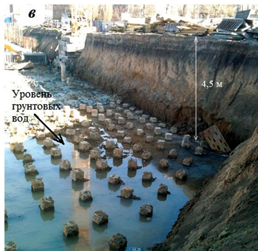
Рис. 1. Схема эталонных площадок проведения геофизических измерений (а); фотографии площадок (б) и котлована, вскрывающего геологический разрез до глубины залегания грунтовых вод (в): 1 — деревья, 2 — асфальтовая дорожка, 3 — разметочная лунка, 4 — подземные коммуникации, 5 — люки, 6 — место заряда
