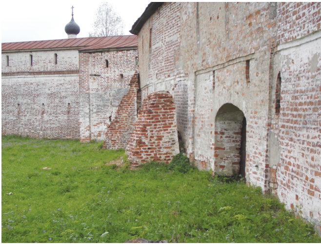
Рис. 2. Отход контрфорсов от крепостной стены XVI в.
