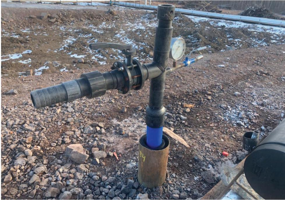
Рис. 6. Общий вид оголовника для выполнения пневмосвабирования
