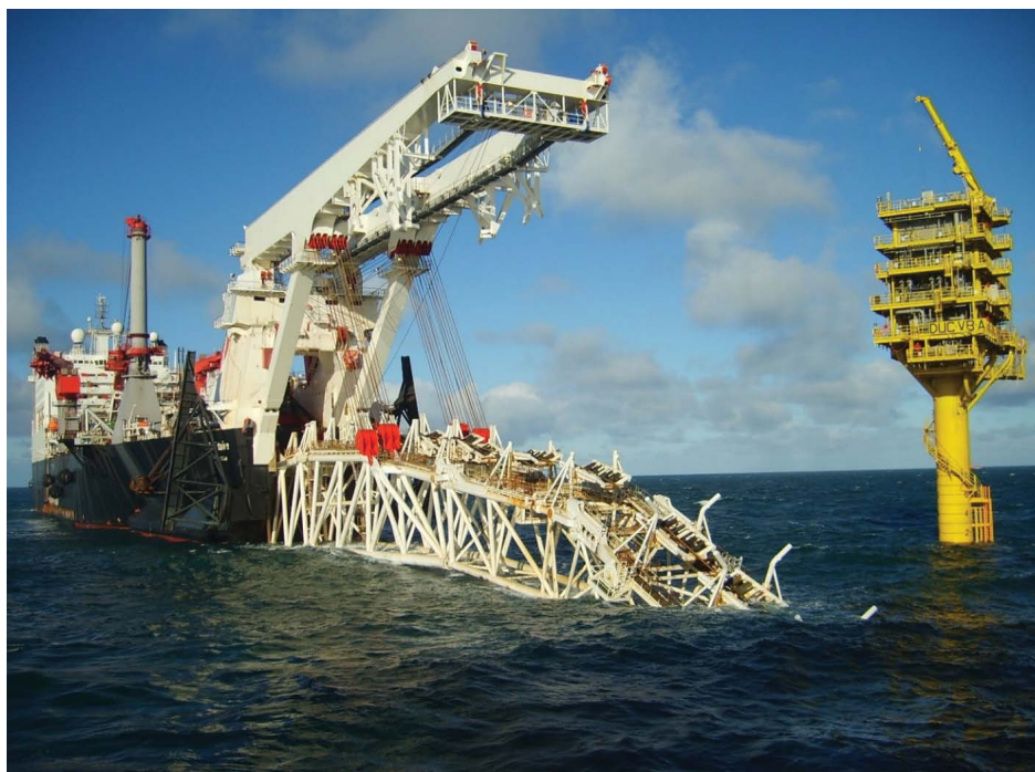
Рис. 2. Укладка трубы газопровода «Северный поток», 2010—2012 гг. [12]
