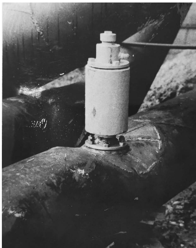
Рис. 2. Шаровой датчик и разделитель с эластичной диафрагмой плотномера (ИГОК): 1 — пульповод Ду = 400 мм; 2 — разделитель; 3 — посадочное место; 4 — шар; 5 — импульсные трубки
