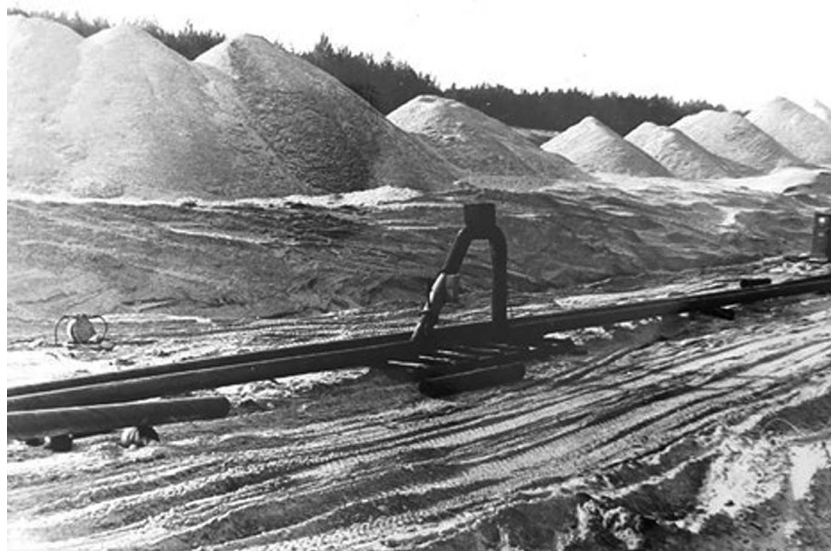
Рис. 8. Передвижная установка измерения параметров гидротранспортирования на расстояние до 2 км из карьера на обогатительную фабрику
